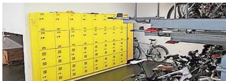
Schliessfächer für Velohelme, E-Bike-Batterien etc. (Beispiel aus der Velostation Schanzenbrücke Bern).
